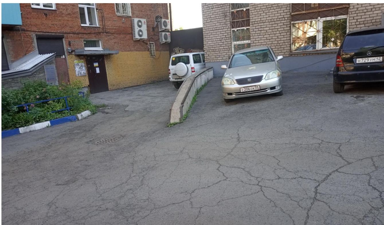
Ливнесток организован в ливневой колодец со сбросом в магистральную ливневую канализацию, расположенную по проспекту Кузнецкстроевский под зданием пристройки.
